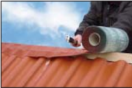
Tacodan Alu-Ventirulle fastgøres til toplægten.
