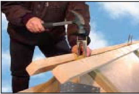
Top-Fix toplægteholder - kun få slag for den nøjagtige position.
