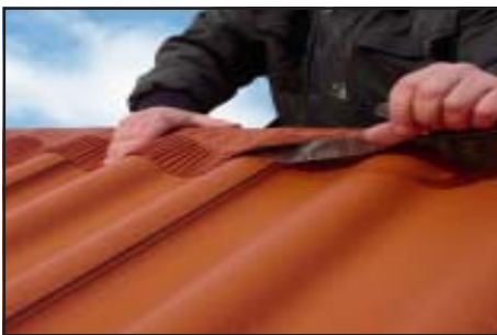
Beskyttelsestape fjernes og ventirullen tilpasses og fastgøres.
